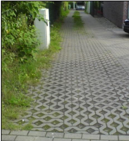
Figur 7-4. Exempel på genomsläpplig beläggning i form av gräsarmerad betongbeläggning (Stockholm Vatten och Avfall, 2017).
