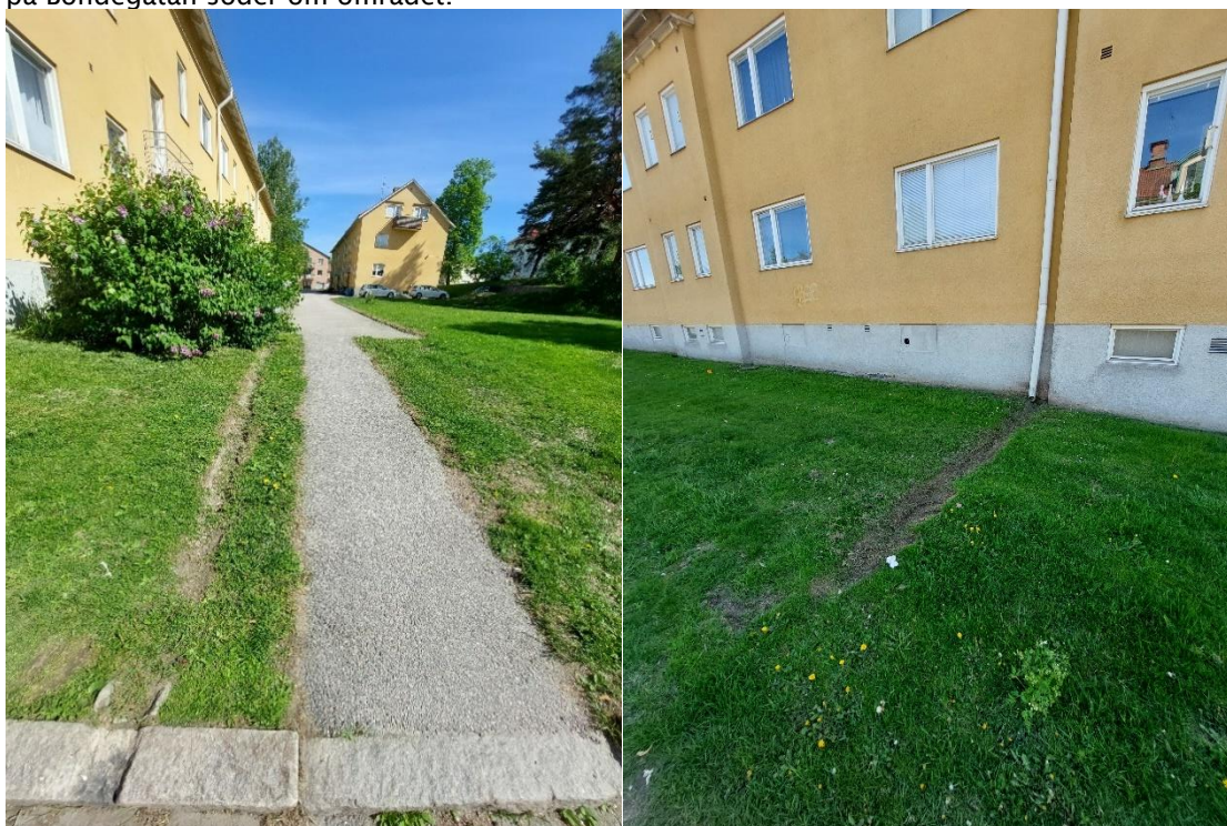
Figur 3-1. Vattenutkastare mot gräsytor och gatorna.
