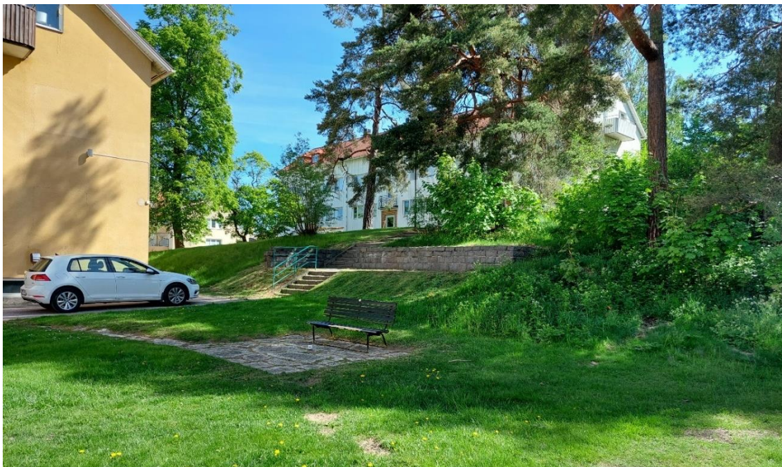
Figur 3-4. Sluttningen inom utredningsområdet har även stödmurar av sten.
